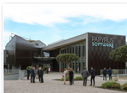
Unternehmenshauptsitz, Wien, Österreich
